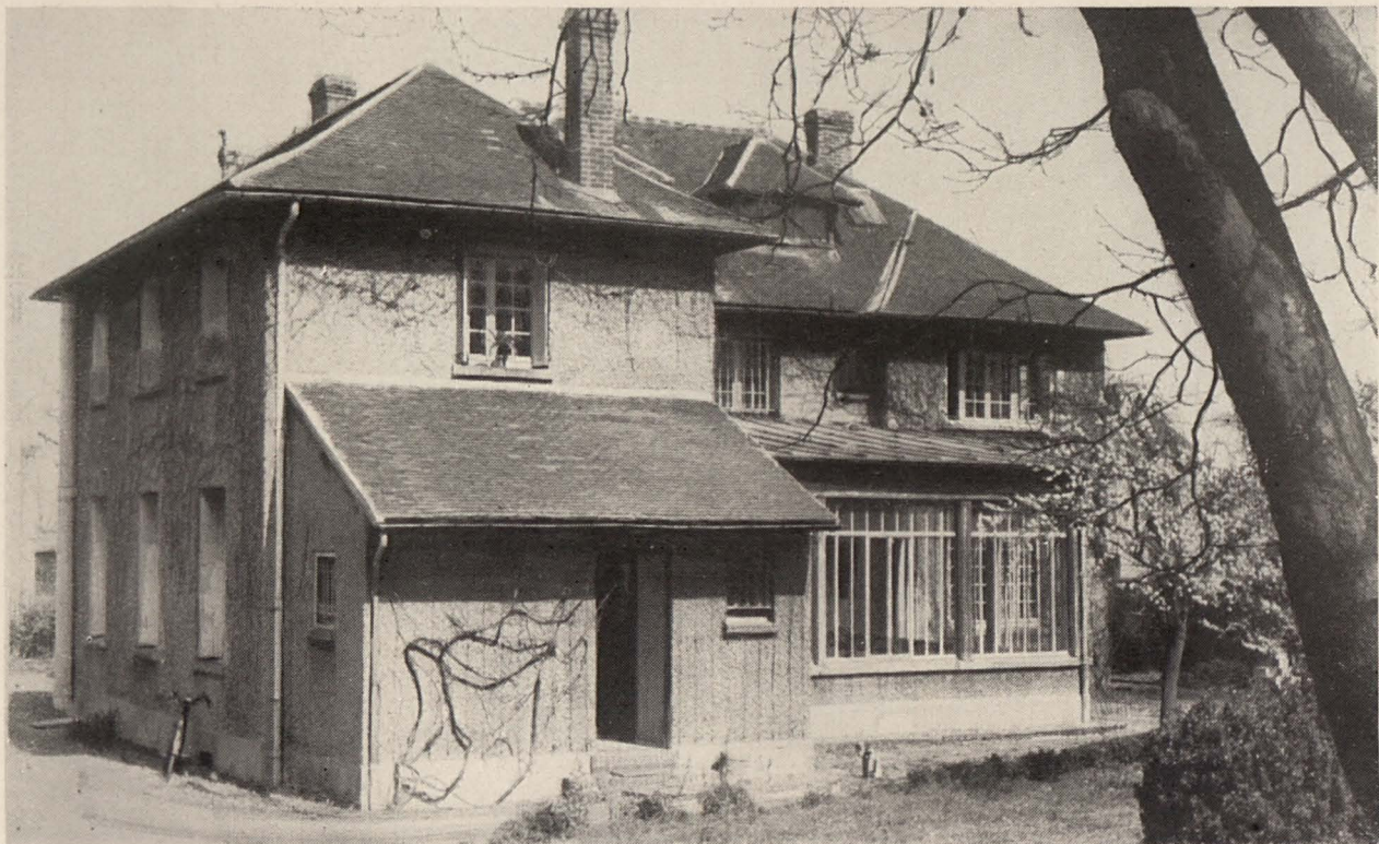
Wejście do domu od strony ogrodu.
