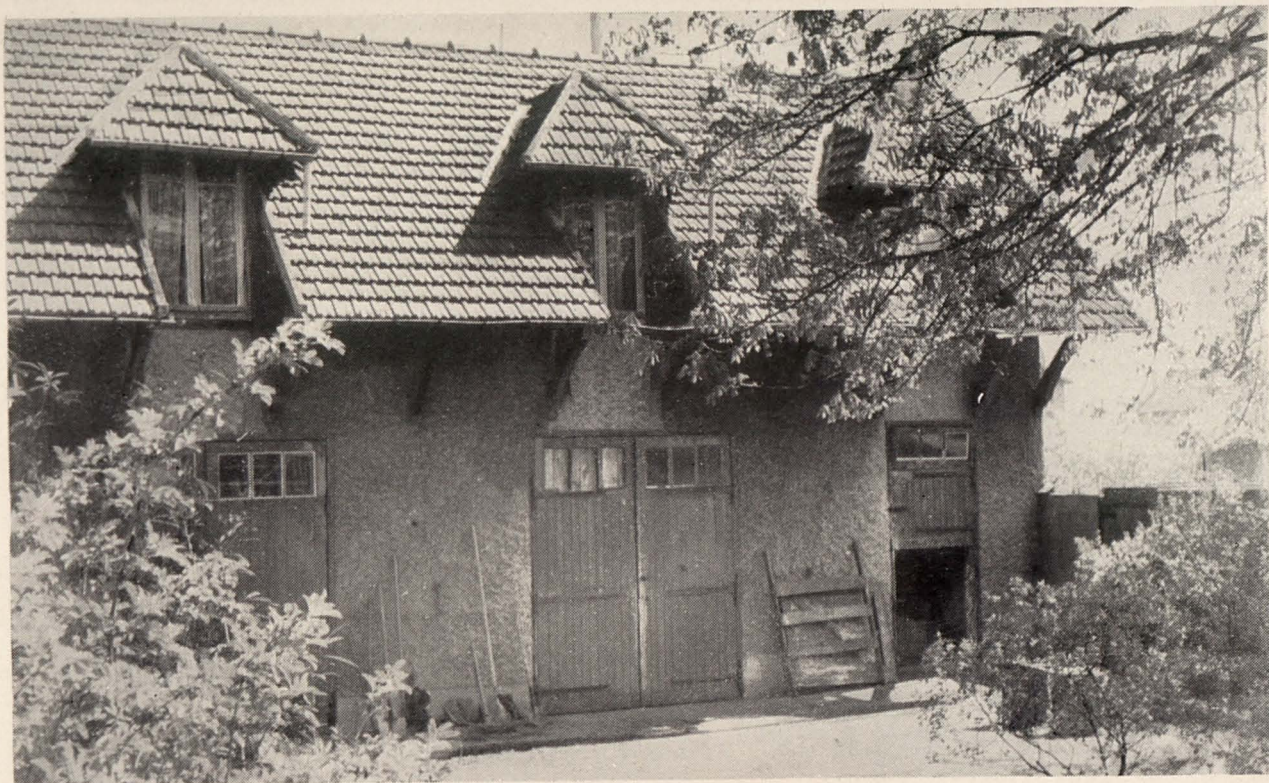
Dawne wozownie. Po remoncie budynku na dole będą magazyny książek i archiwa, a na piętrze pokoje klubowe i gościnne.
