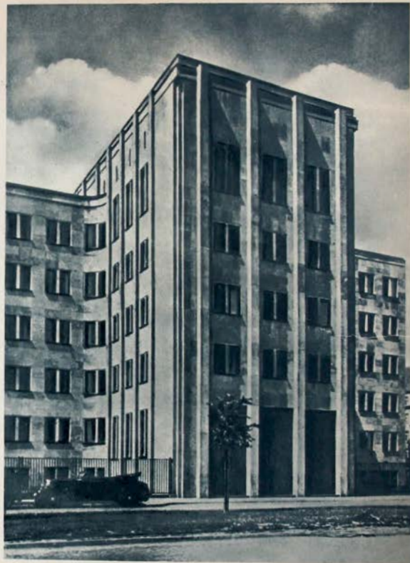
5. - Nowy gmach Kierownictwa Marynarki Wojennej w Warszawie, przy ul. Wawelskiej — był ostatnim wyrazem nowoczesnego budownictwa.
